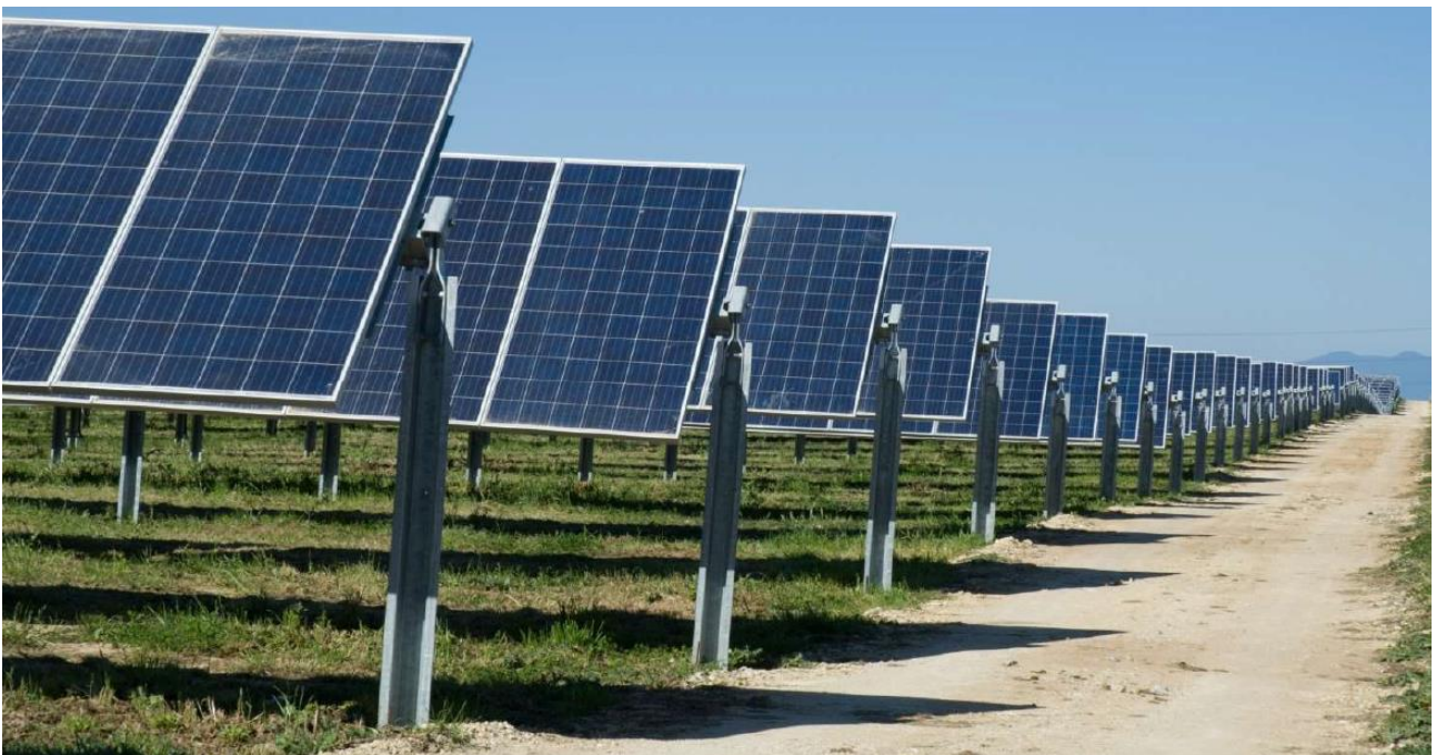
Figura 6 - immagine esemplificativa di inseguitori mono-assiali in configurazione 1P
